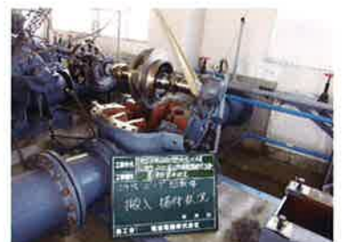
施工状況 NO2ポンプ
