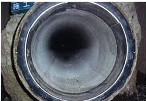
施工後 (内面更生工)
