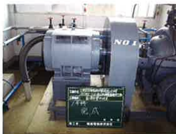
施工後 NO1ポンプ
