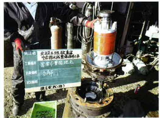
ポンプ解体状況
