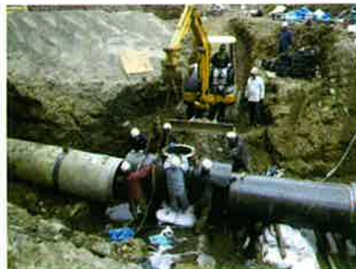
鋼管部布設状況
