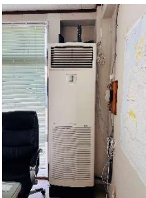
空調設備更新 (戸面原ダム管理棟)
