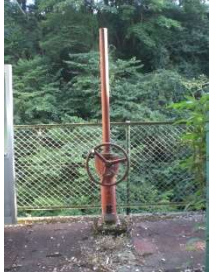
隧道流入工 スライドゲート (塗装補修)
