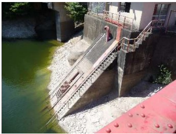
斜樋ゲート 塗装補修
