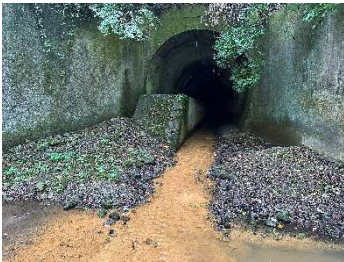
仮排水トンネル (表面被覆)
